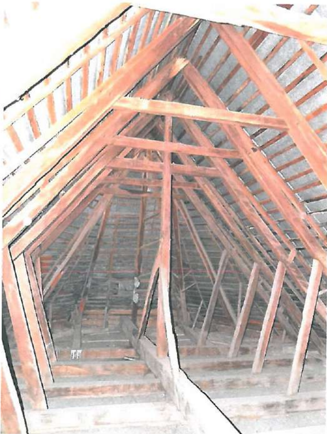
4.4. Vedere de ansamblu spre est, zona de închidere a șarpantei; materialul lemnos folosit la realizarea șarpantei este de esență tare (stejar)
