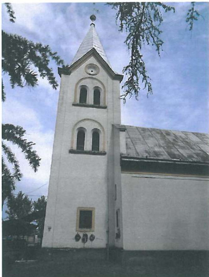
1.6. Fațada sud a turnului bisericii; racordul turnului cu nava bisericii
