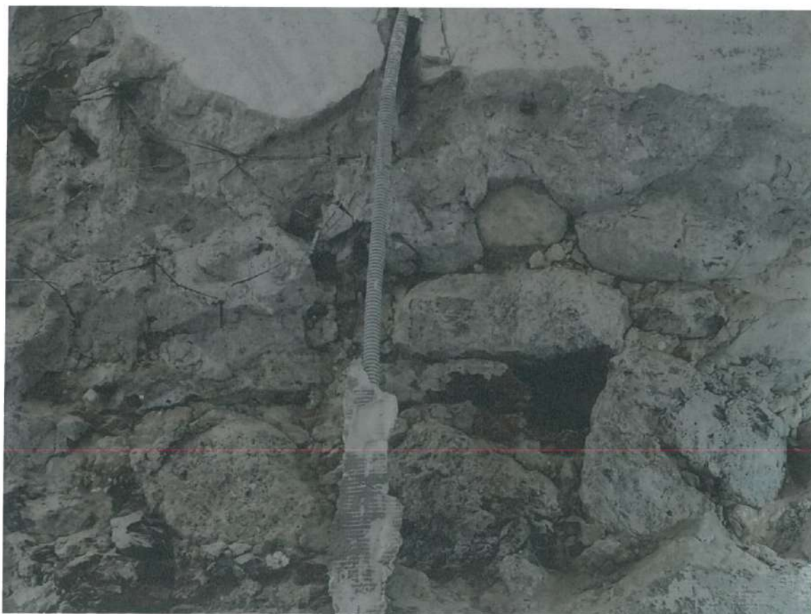
Foto 8. Starea zidăriei în interior
