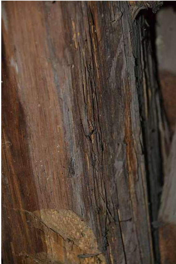
Foto 3-4.: Căprior și colțar transversal cu orificii de zbor și galerii destrămate de Anobium punctatum , fermele 2a și 4d
