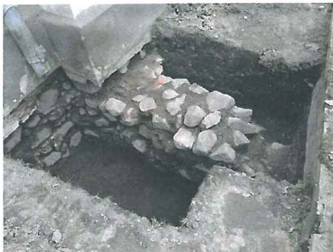
1.23. Racord cor-navă biserică, fațada nord - sondajul geotehnic/ arheologic S02 - fundație din zidărie de piatră, dezveliri de fundații adiționale, probabil ale sacristiei de odinioară, adâncimea tălpii fundației față de CTN: 0.90m (cf. studiu geotehnic)
