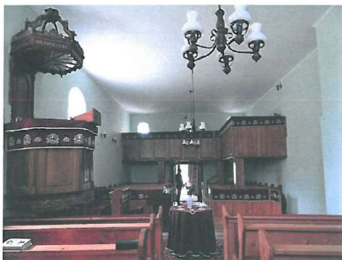
2.3. Interiorul bisericii, vedere spre navă; tribuna de vest realizată în anul 1978 din beton armat, placată cu panouri de lemn
