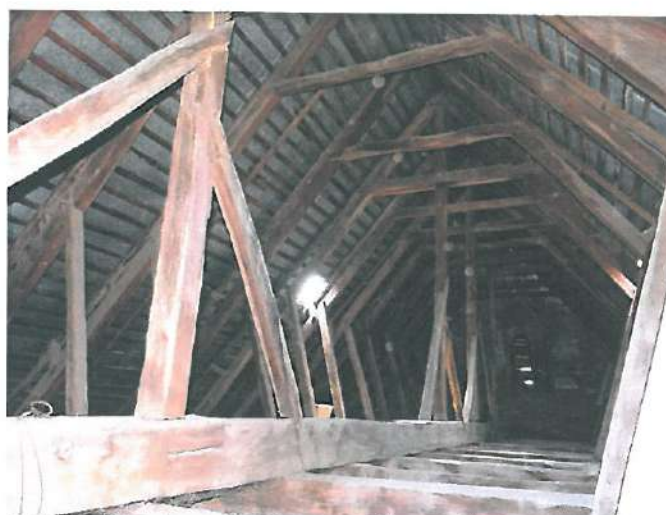
4.1. Vedere de ansamblu șarpantă cu caracter gotic, având un sistem longitudinal de rigidizare alcătuit din grinda de suspendare așezată pe corzile șarpantei, din barele de agățare a fermelor principale și din colțari longitudinali
