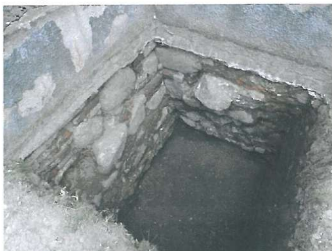
1.24. Racord navă-turn biserică, fațada vest/ nord - sondajul geotehnic/ arheologic S03 - fundație din zidărie de piatră, adâncimea tălpii fundației față de CTN: navă - 1.40m, turn - 1.20m (cf. studiu geotehnic)
