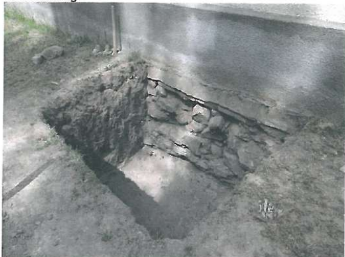
1.11. Navă biserică, fațada nord - sondajul geotehnic/arheologic S04 - fundație din zidărie de piatră, adâncimea tălpii fundației față de CTN: 1.00m (cf. studiu geotehnic)
