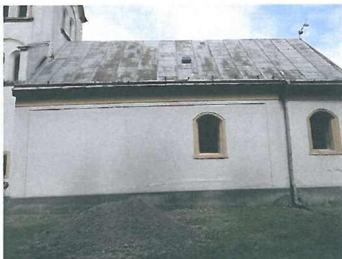
1.7. Navă și cor biserică, fațada nord - soclul pereților cu umiditate ridicată, persistentă pe tot conturul bisericii
