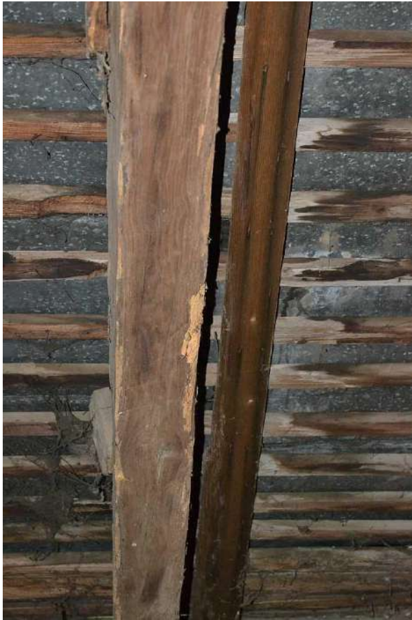
Foto.1.: Căprior de gorun cu galerii de Anobium punctatum pe alburn - ferma 1a.
