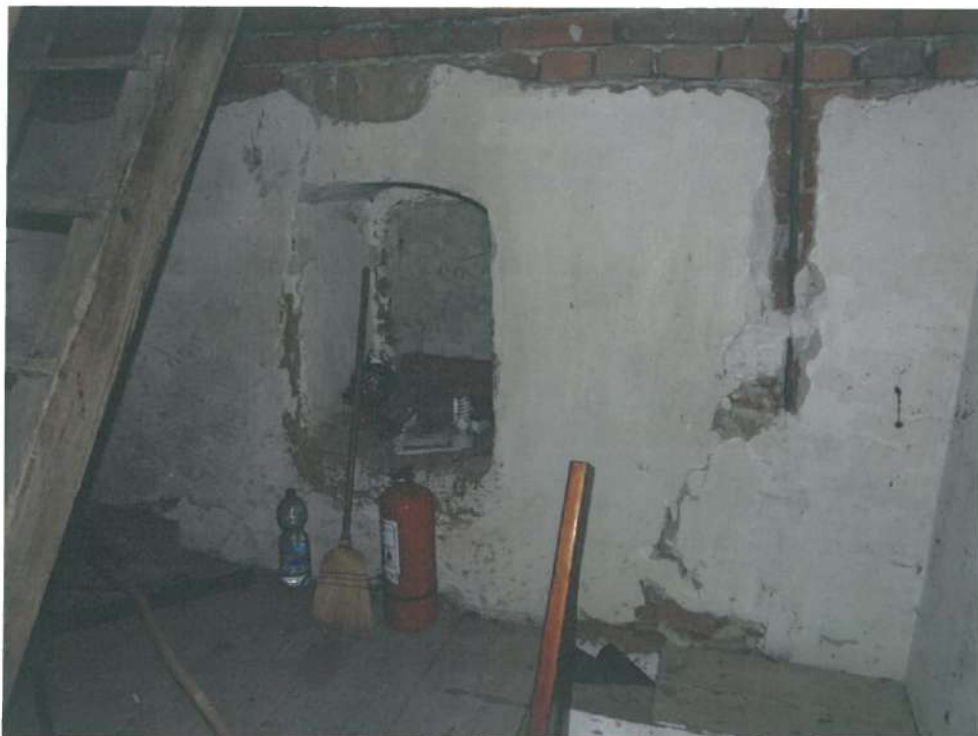
Foto 12. Gol de fereastră înzidit la nivelul al doilea al turnului
