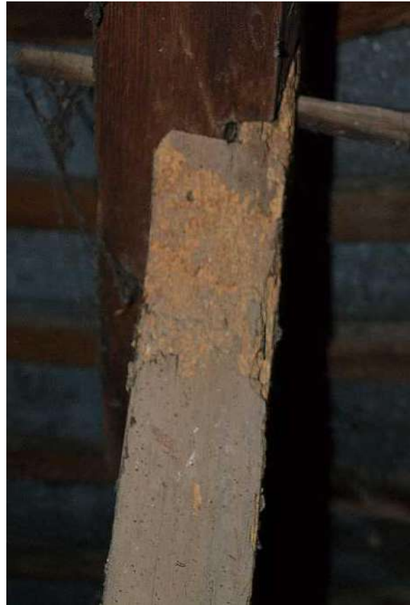
Foto 3-4.: Căprior și colțar transversal cu orificii de zbor și galerii destrămate de Anobium punctatum , fermele 2a și 4d
