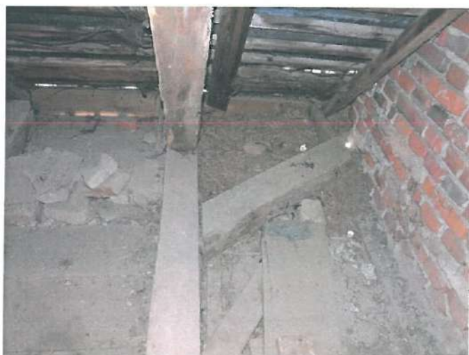
4.3. Se observă două grinzișoare așezate în diagonală în cele două colțuri ale șarpantei adiacente turnului, acestea indicând urmele unei șarpante anterioare construirii turnului, probabil teșite spre vest
