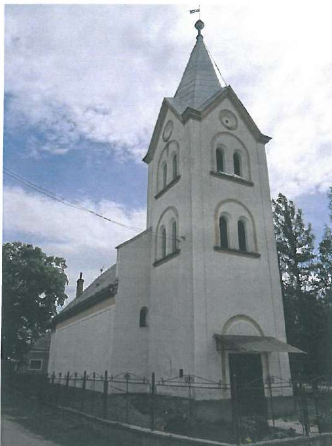
1.1. Vedere de ansamblu biserică din nord-vest, având atât soclu, cât și tencuială pe bază de ciment, aplicat pe toate suprafețele bisericii
