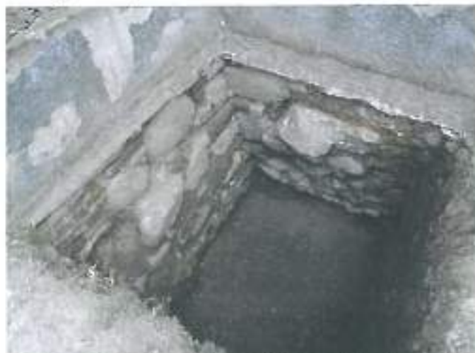
1.24. Racord navă-turn biserică, fațada vest/ nord - sondeajul geotehnic/ arheologic S03 - fundație din zidărie de piatră, adâncimea tălpii fundației față de CTN: navă - 1.40m, turn - 1.20m (cf. studiu geotehnic)
