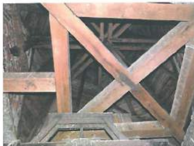
3.6. Sistemul spațial al coifului având trei nivele orizontale de rigidizare
