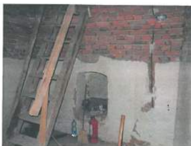
3.2. Primul nivel superior al turnului - nișă realizată în zidul vestic al turnului; pereți din zidărie de cărămidă tencuiți aproximativ la jumătatea înălțimii, scară de acces din lemn cu balustradă la următorul nivel
