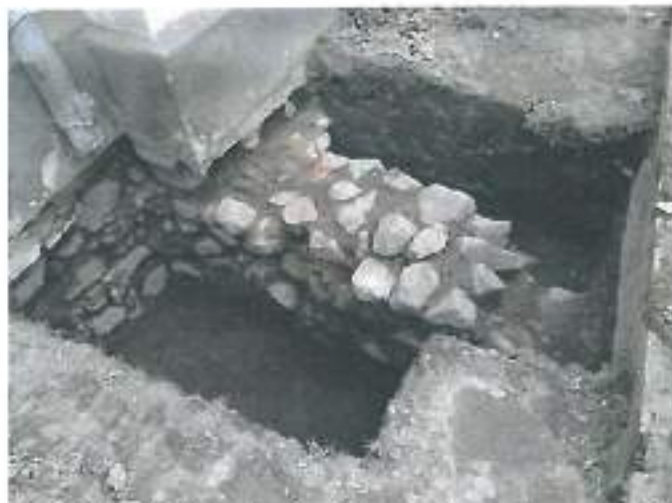
1.23. Racord cor-navă biserică, fațada nord - sondeajul geotehnic/ arheologic S02 - fundație din zidărie de piatră, dezveliri de fundații adiționale, probabil ale sacristiei de odinioară, adâncimea tălpii fundației față de CTN: 0.90m (cf. studiu geotehnic)
