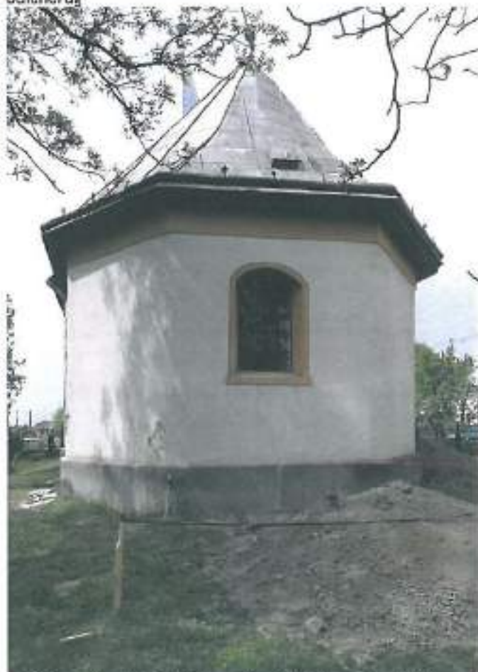
1.17. Cor biserică, fațada est - subzidirea fundațiilor s-a efectuat în anul 2011, pe latura nord a corului și parțial a navei, pornind de la geamul corului și oprindu-se la fereastra navei
