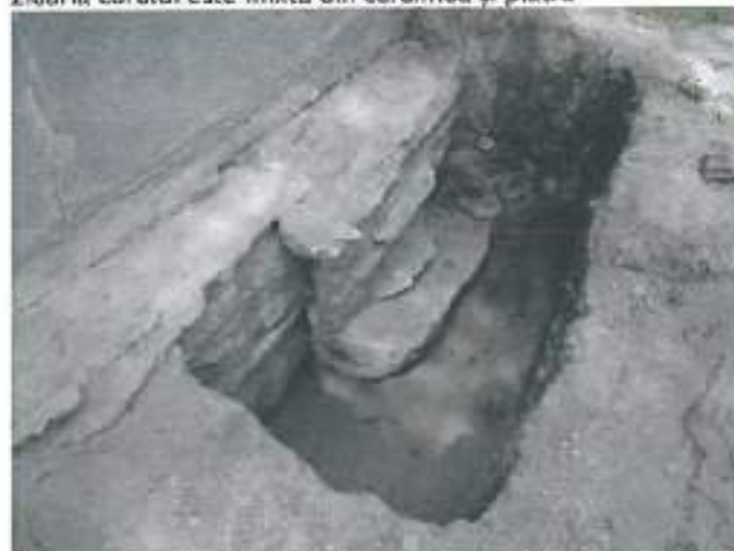
1.16. Cor biserică, fațada est - sondajul geotehnic/ arheologic S01 - subturnare de beton, se pare că turnarea betonului s-a efectuat mai mult pe lângă și nu sub fundație; adâncimea tălpii fundației subturnate față de CTN: 1.10-1.20m (cf. studiu geotehnic)
