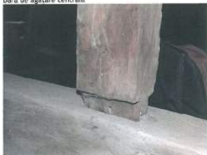
4.7. Subansamblul șarpantă este caracterizat de noduri dislocate sau concepute greșit - nod bară de agățare - grindă de suspendare dislocată
