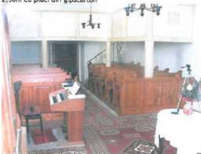
2.4. Poză de arhivă cu tribuna de vest din beton armat, înainte de placarea acesteia cu panouri de lemn
