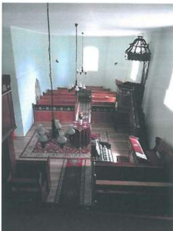
2.2. Interiorul bisericii - vedere spre cor - cu finisaje recente, inclusiv acoperirea pereților pe o înălțime de aprox. 2,50m cu plăci din gips carton
