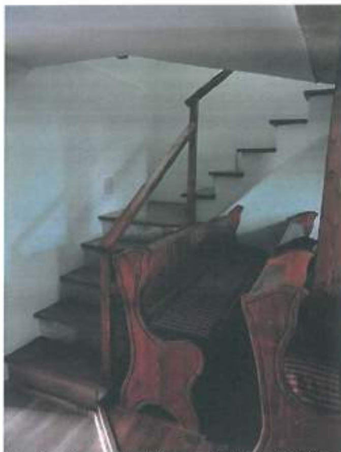
2.5. Scară de acces din beton armat la tribuna bisericii; gol de ventilare a pereților acoperiți, distanțați cu plăci de gips carton
