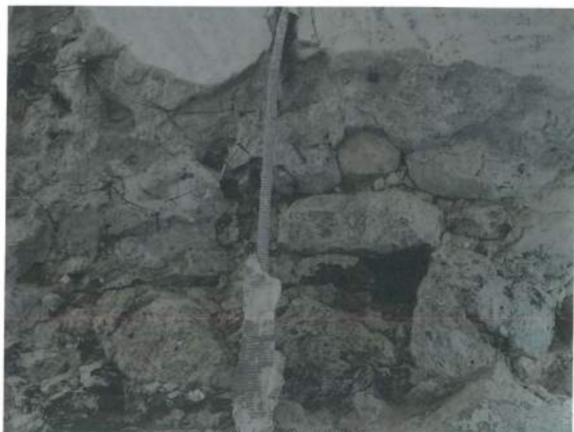
Foto 8. Starea zidăriei în interior
