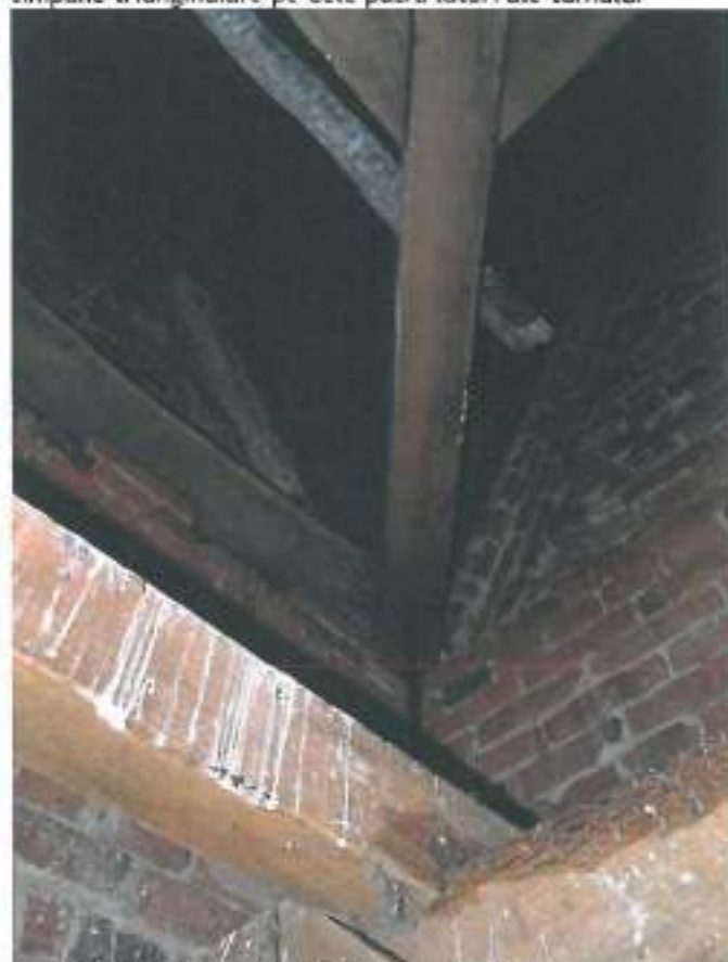
3.8. Structura coifului ancorat prin tiranți în grinzi de lemn așezate în cele patru colțuri ale turnului
