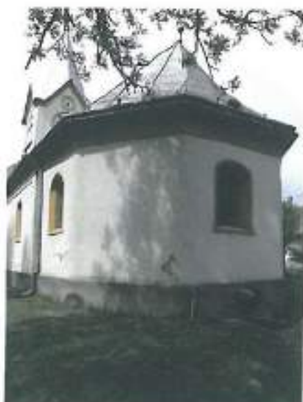
Foto 2. Biserica reformată văzută dinspre est, absidă poligonală
