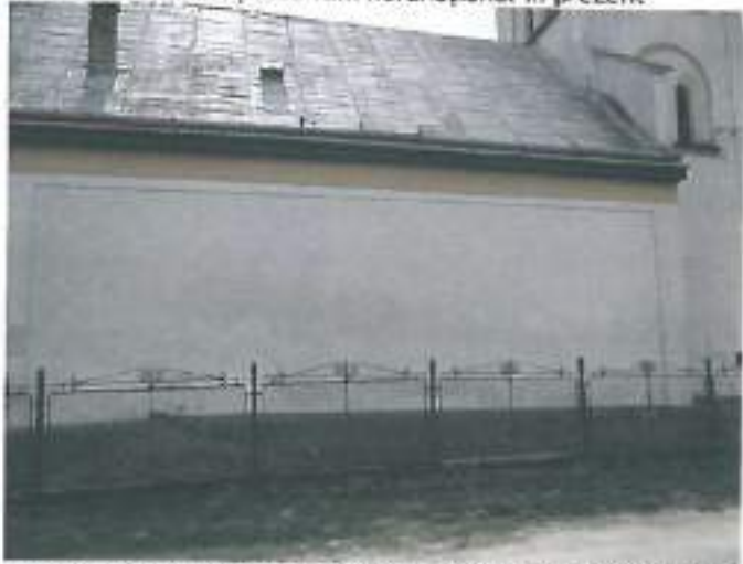
1.22. Navă biserică, fațada nord - soclu și tencuială pe bază de ciment, învelitoare din tablă
