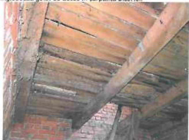
3.4. Planșeele turnului sunt din lemn cu grinzi distanțate și podite
