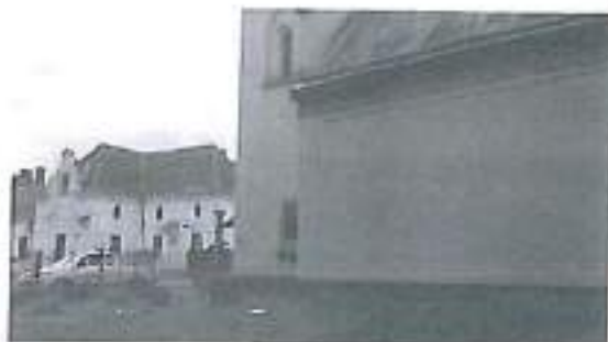
Fig. 1. Execuție foraj geotehnic FG01
