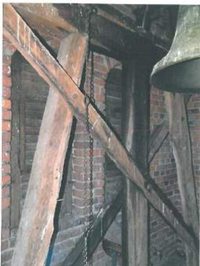
3.5. Nivelul III turn - Sistemul de susținere a clopotelor din lemn
