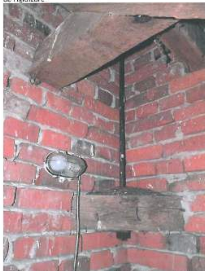
3.8. Structura coifului ancorat prin tiranți în grinzi de lemn așezate în cele patru colțuri ale turnului
