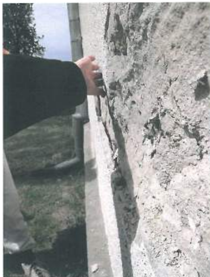
1.15. Cor biserică, fațada nord - pe baza cercetărilor in situ , pereții navei și corului sunt acoperiți cu tencuială pe bază de ciment, după care urmează o tencuială pe bază de var, iar zidăria corului este mixtă din cărămidă și piatră
