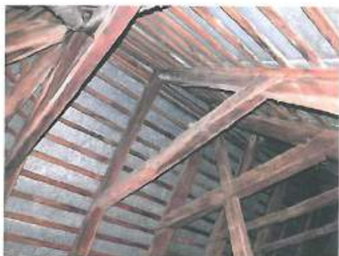
4.12. Îmbinări în coadă de rândunică rigidizate prin cuie de lemn, tipice șarpantelor cu caracter gotic - îmbinare moază-câprior
