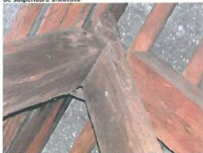
4.8. Nod bară de agățare - pereche de căpriori greșit concepută și dislocată, mod de lucru deficitar
