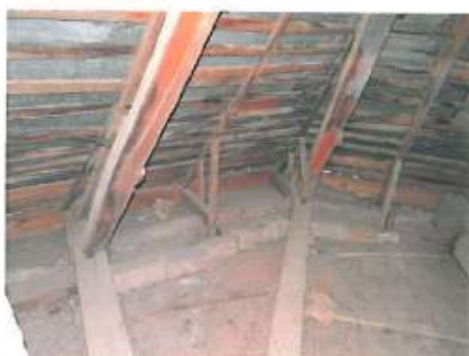
4.11. Îmbinări tip cepuire, înclinate, dislocate între câpriori și semicorzi în zona închiderii șarpantelor, moduri de lucru deficitare
