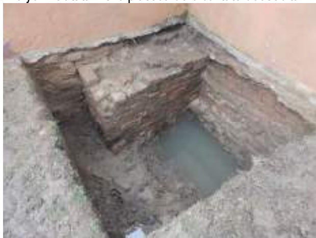
Contrafort gotic descoperit de cercetările arheologice
