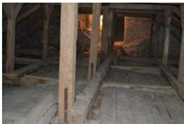
34. Vedere generală șarpantă – spre Vest.
