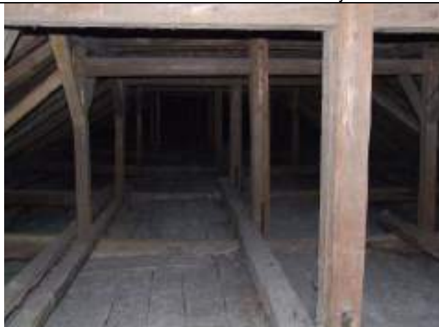
33. Vedere generală șarpantă – spre Est.
