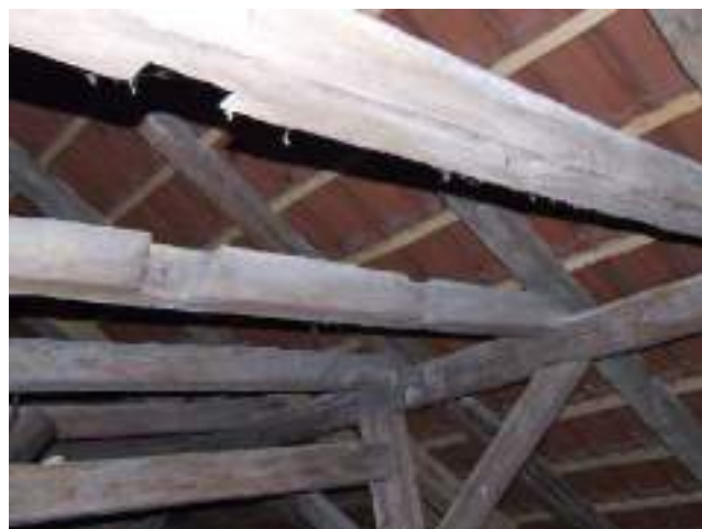
39. Elemente refolosite dintr-o șarpantă anterioară.
