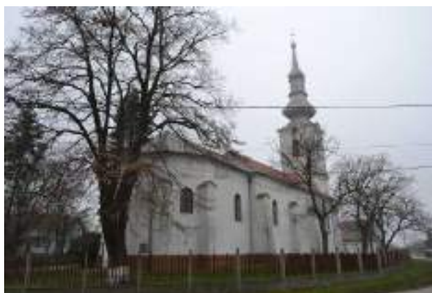
10. Vedere generală fațada nordică.
